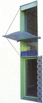
nube marquesina exterior-fachada s.XIX claraboya translúcida y cable de acero trenzado
