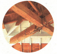
lecho esponja interior-torre s.XV pintura reflectante sobre estructura original
